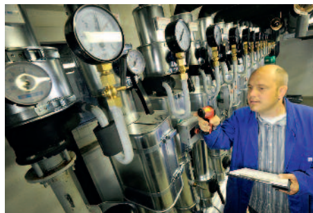
Mit dem Projekt Energiecoach unterstützt die IHK Chemnitz Unternehmen bei der Erschließung von Energieeinsparpotenzialen und Effizienzmaßnahmen.
