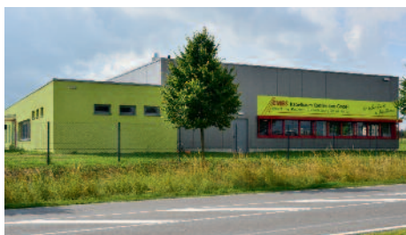
Die EMES Kabelbaum Konfektions GmbH in Amtsberg bei Chemnitz deckt mit ihrer Fertigung ein umfangreiches Branchenspektrum ab. Foto: Wolfgang Schmidt
